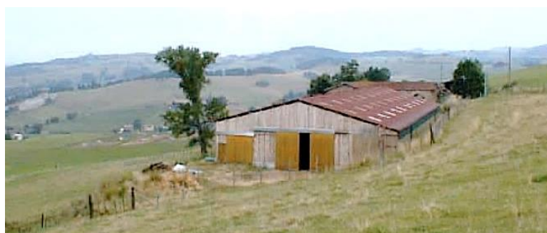
Exemple de bâtiment contemporain inscrit dans la pente
