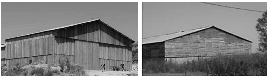
Exemples de bâtiments revêtus de bardages en bois (lames verticales ou clins) avec ou sans soubassement maçonné.
