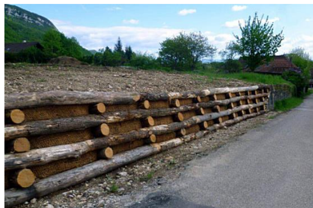
Gabions en bois en zone agricole, une alternative qui s'accorde assez bien avec le paysage naturel. Scs : Chambre d'Agriculture de Savoie.
