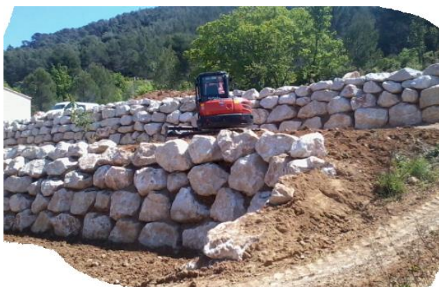
Enrochements calibrés en terrasses, permettant de limiter les hauteurs de soutènement. A droite, blocage de pied de talus en enrochement, une solution pour réaliser un aménagement à taille humaine de la pente et des abords.
