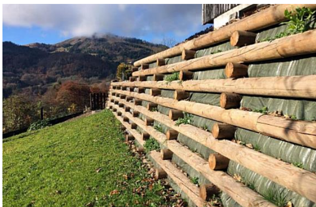
Gabions en bois en zone agricole, une alternative qui s'accorde assez bien avec le paysage naturel. Scs : Chambre d'Agriculture de Savoie.
